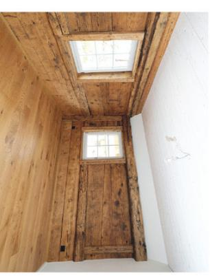
Fachgerecht sanierte Bohlenwände nicht nur in den Zimmern des 1. Obergeschosses.
